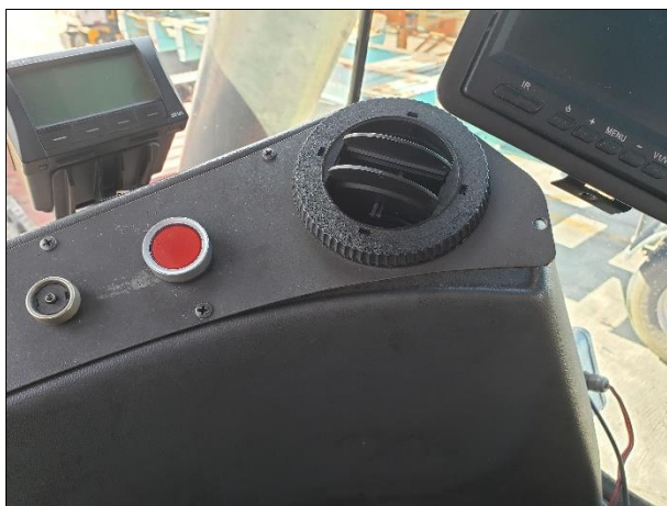
# item 5 – painel faltando parafusos de fixação
