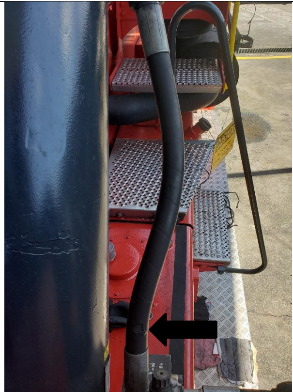
# item 45 – mangueira do bloco cilindro de elevação lado esquerdo apresenta trama exposta
