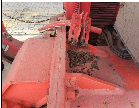
# item 5 – pontos com corrosão
