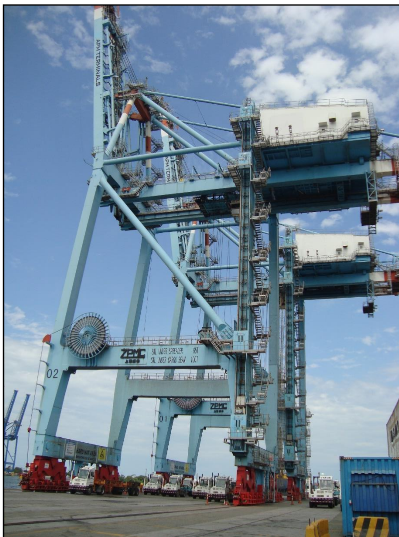
Figura 1. Guindaste de cais (portainer), STS-02.
